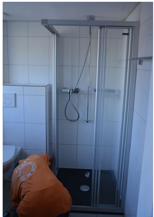
Letzte Arbeiten am neuen Bad.
